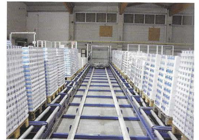
Automatische Nachversorgung Kommissionierzone
