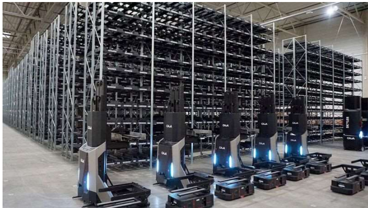
Erster Robotertest im neuen Lager von Caja Robotics: Die Installation wurde umgesetzt mit dem Integrationspartner Hörmann Intralogistics. (Bild: Caja)
